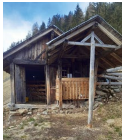
Bergstation Materialseilbahn Larcherberg
